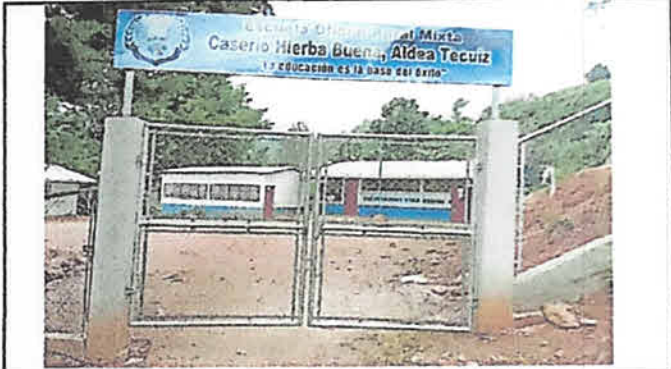
Foto 4: Fundición de columnas de concreto para la sujeción del portón e instalación de portón de dos hojas de tubo y malla galvanizada.
