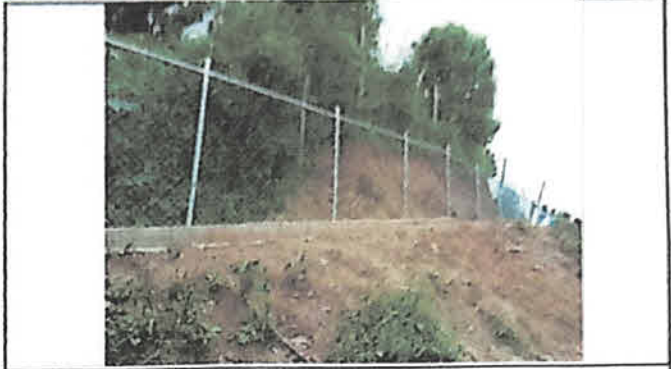
Foto 2: Tramo largo de colocación de malla terminado
