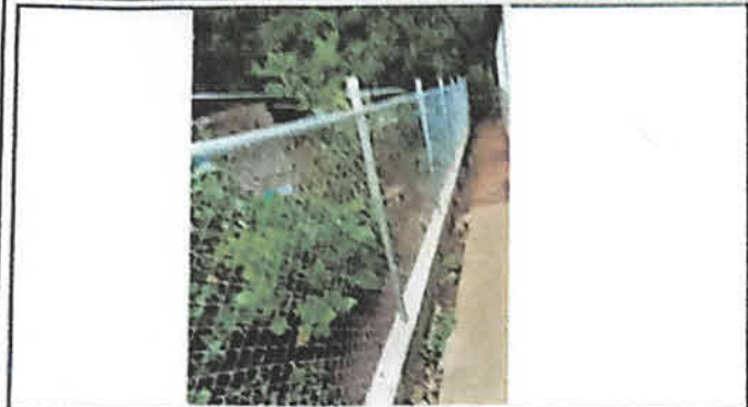
Foto 1: Malla tensada y fundida dentro del concreto de la solera de block tipo U
