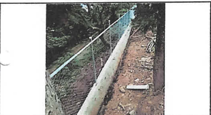
Foto 5: Muro de contención terminado y colocación de malla con las mismas dimensiones sobre el muro.
