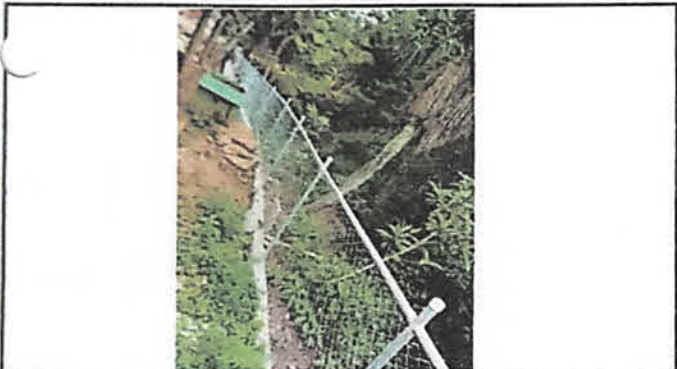
Foto 3: Totos los tramos estan terminados y se colocación tapones de pvc sobre los postes de tubo de 1 1/2"
